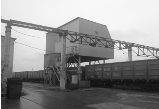
Рис. 2 Общий вид 3-х модульной ВРУ в морском торговом порту «Южный»
